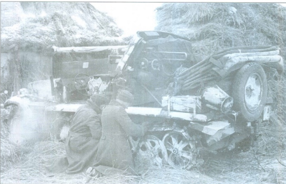
SdKfz 10 met een 5 cm PaK. Dit was geen officiële variant, maar een veldmodificatie.
